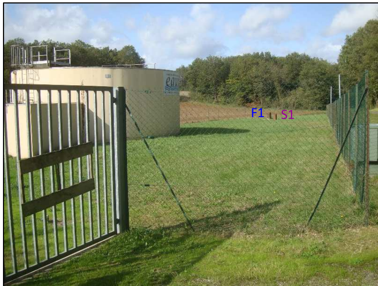
Vue générale vers le nord/nord-ouest (au premier plan : portail et station de surpression)
