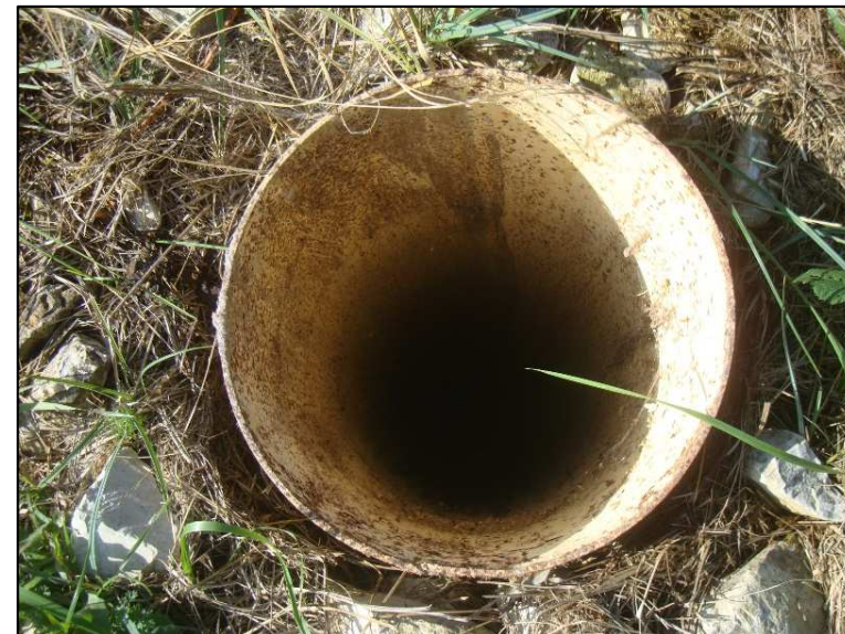
Vue de l'intérieur du sondage S1 (tubage acier ordinaire Ø 323 mm)
