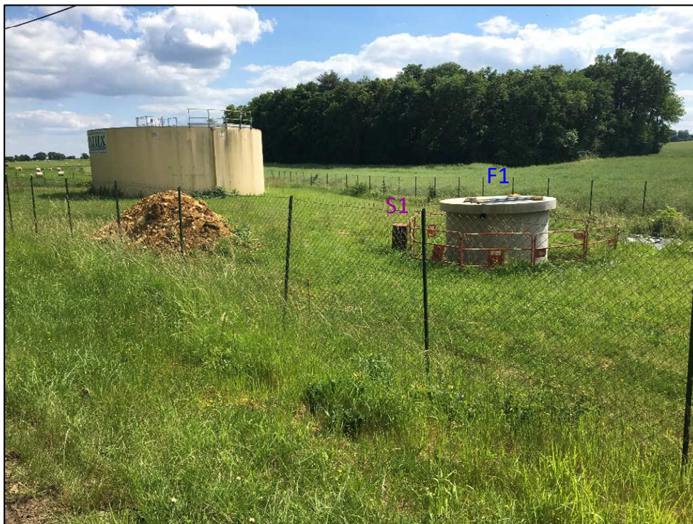
Vue générale vers le sud (en arrière plan à gauche : station de surpression)
